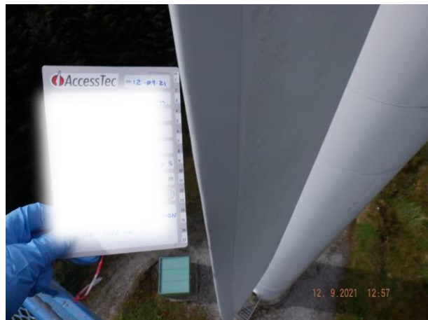
Edge Sealant Applied SS Edge Sealant Applied PS
